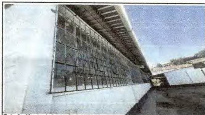
Foto 3: Mantenimiento de balcones
