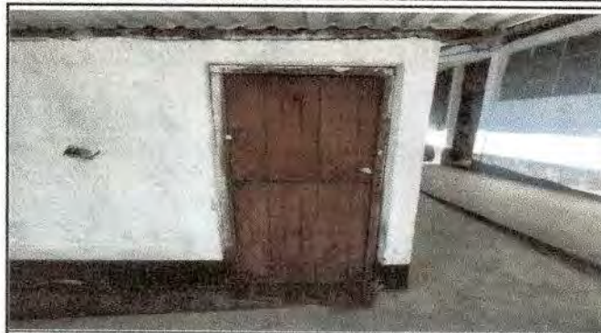
Foto 2: Sustrucción de puerta de madera a metal
