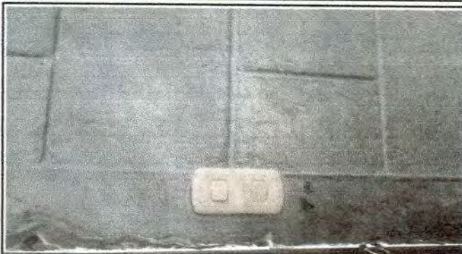
Foto 13: Sustrucción de interruptores dobles
