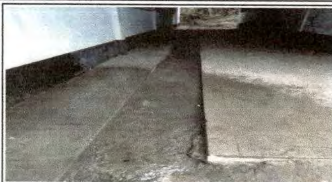
Foto 8: Reparación de cuneta de concreto
