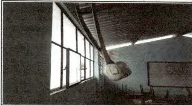
Foto 19: Sustitución de ducto eléctrico
