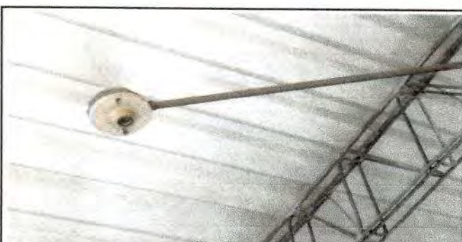
Foto 12: Sustitución de plafoneras
