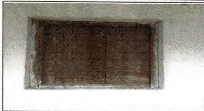
Foto 1: Sustrucción de ventanas de madera a metal mas vidrios
