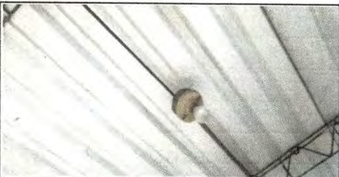
Foto 11: Sustitución de focos ahorradores
