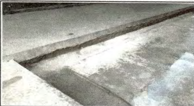
Foto 7: Reparación de banquetas de concreto
