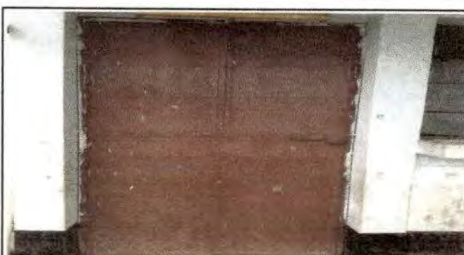
Foto 10: Aplicación de pintura a puerta de metal
