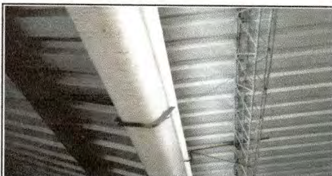
Foto 6: Sustrucción de pescante de metal para canal
