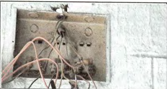
Foto 17: Sustrucción de tablero de flipones
