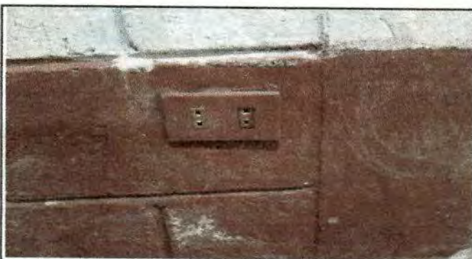
Foto 15: Sustrucción de tomacorrientes dobles
